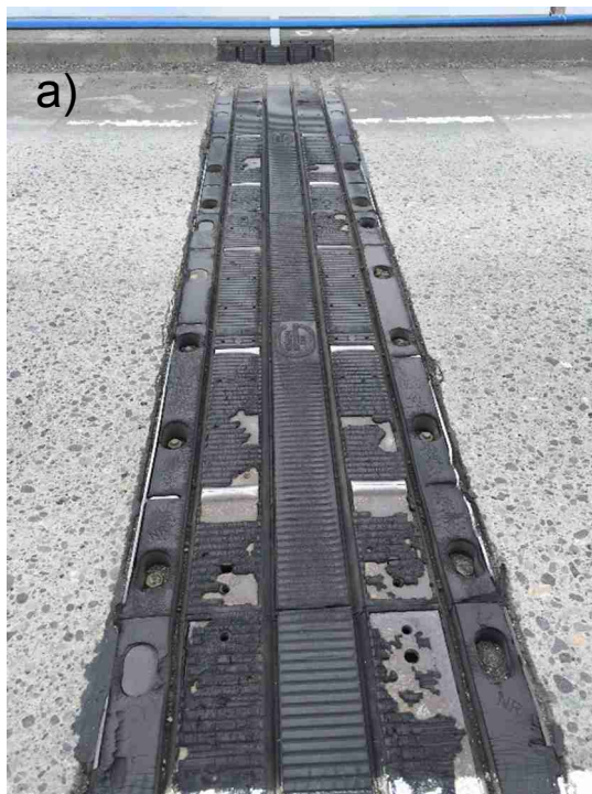
Mynd 1: a) Dæmi um hefðbundna mekanískri þenslufúgu, mynd tekinn á Borgarnesbrú. b) Dæmi um tæringu á legu og undirstöðu brúar vegna leka í þenslulið á yfirborði (Ho & Lukashnko, 2011).
